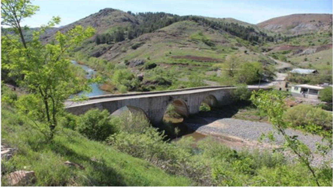
Foto 17. Ergani ilçesi Değirmendere köyünde bulunan tarihi Kalem Bridge Köprüsü (Çetin, 2017).
