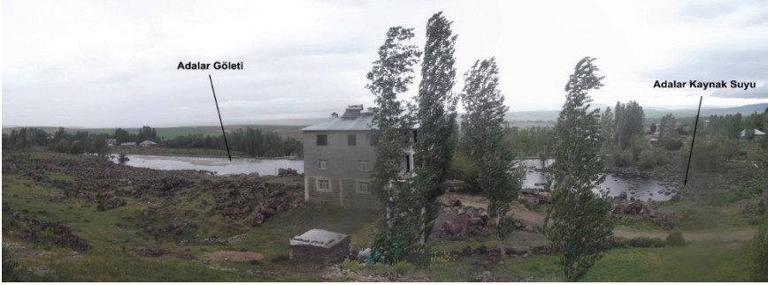
Foto 4: Bulanık-Malazgirt Havzası'nda Malazgirt İlçesi'nde Bulunan Adalar Kaynak Suyu ve Göleti (Bakış Kuzeybatıya).
