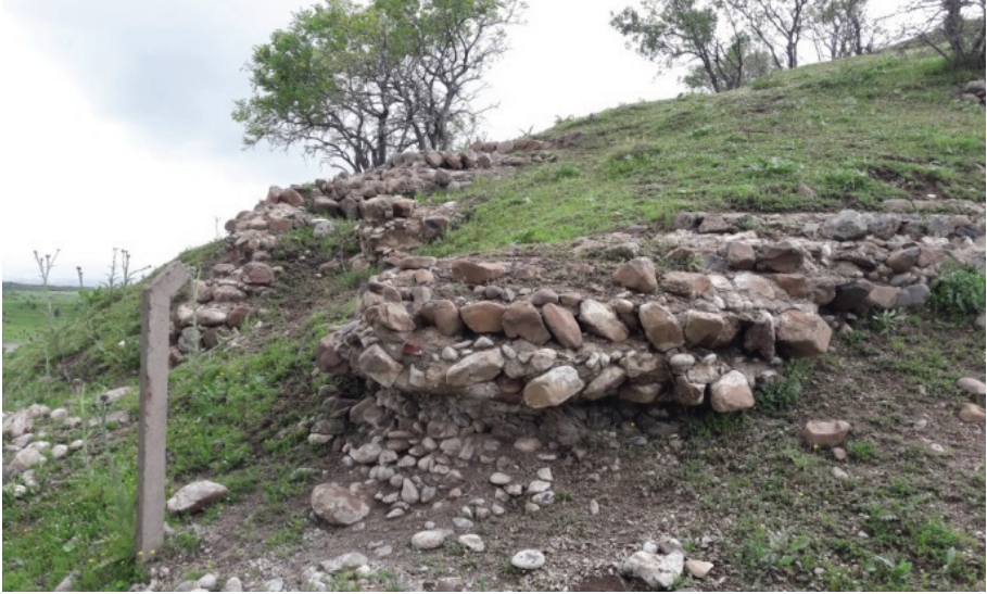
Foto 8: Kalenin Giriş Kısımında Kalan Kalıntı
